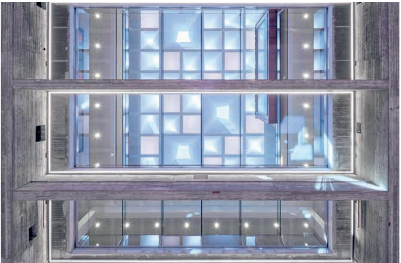
Langs oude betonnen liggers met glazen kappen heb je vanuit de evenementenhal zicht op het bijzondere dak met de lichthappers. (Foto: Ronald Tilleman)
