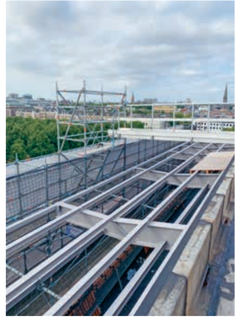
Veilig werken rond de staalconstructie van de luifel. (Foto: Kuijpers)
