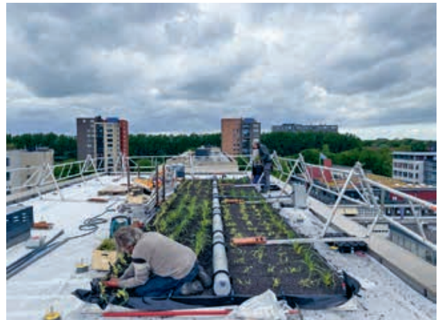
Aanleg helofytenfilter voor de zuivering van grijswater.
