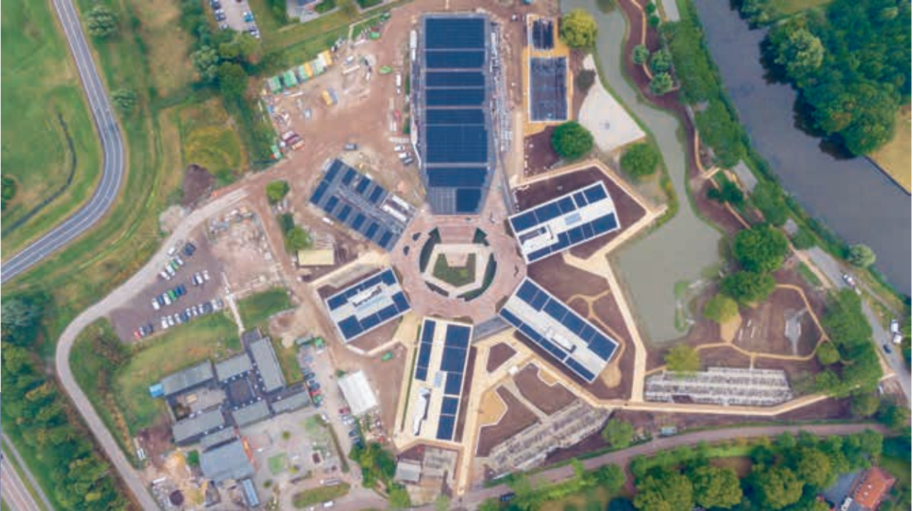
Op alle vleugels liggen zonnepanelen. (Foto: CARLISLE® CM EUROPE)
