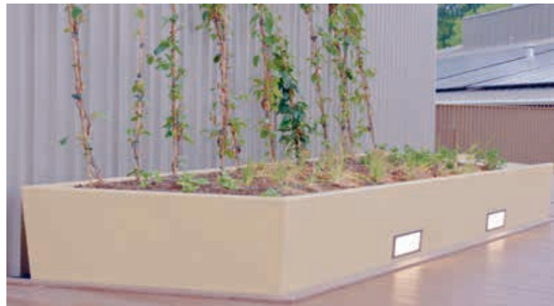
Plantenbak op de rondgang. (Foto: Jalving)
