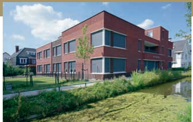
Weinig ruimte om het zorggebouw, dan maar het dak op.
