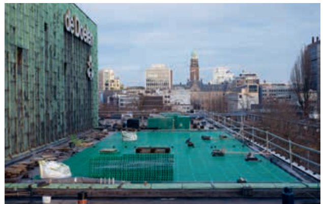
De retentiekraften zijn samen goed voor 300 m3 waterberging. (Foto: Jan van der Ploeg)
