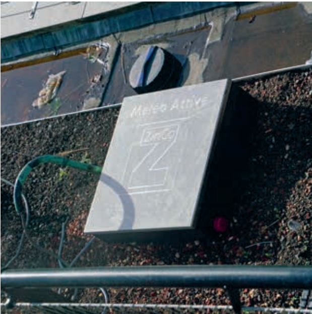
Het dak is uitgerust met tien Meteo Active putten. (Foto: Tjerk van Duinen)
