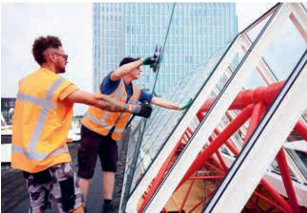
Montage glaspanelen in lessenaarsconstructie.
